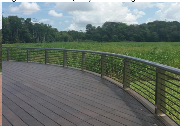
Figura 28: Mirante (Pier) sobre o Lago Bolonha
