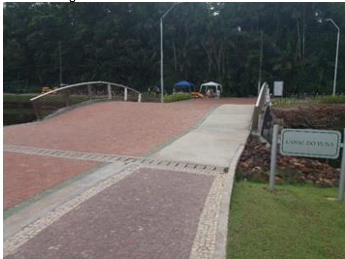
Figura 26: Ponte sobre o Canal do Yuna
