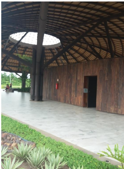
Figura 21: Entrada do auditório do Centro de Acolhimento
