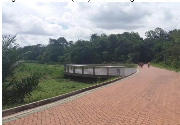
Figura 27: Mirante (Pier) sobre o Lago Bolonha
