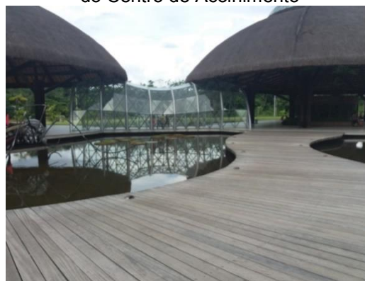
Figura 20: Passarela que interliga as Malocas do Centro de Acolhimento
