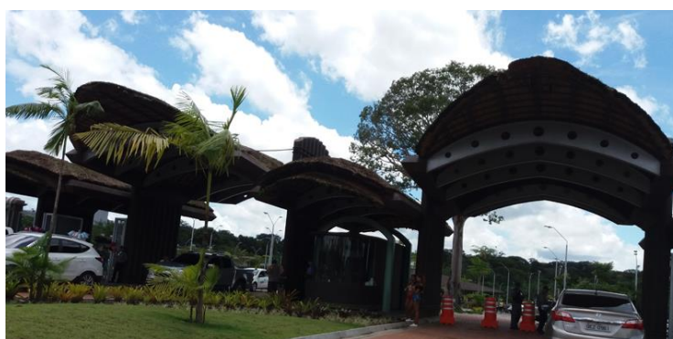
Figura 17: Pórtico de Entrada do Parque
